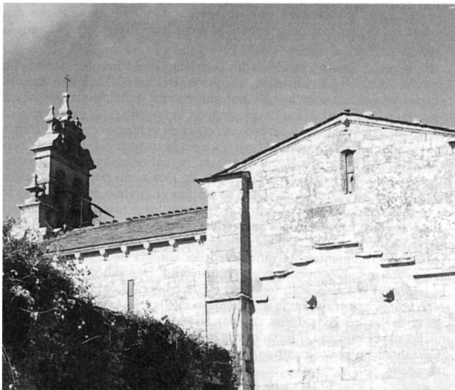
Lámina 1.- En el extremo sur del crucero se aprecian los dos canecillos en forma de proa que sostendrían las vigas de madera y el alero volado y escalonado de las dependencias monásticas
